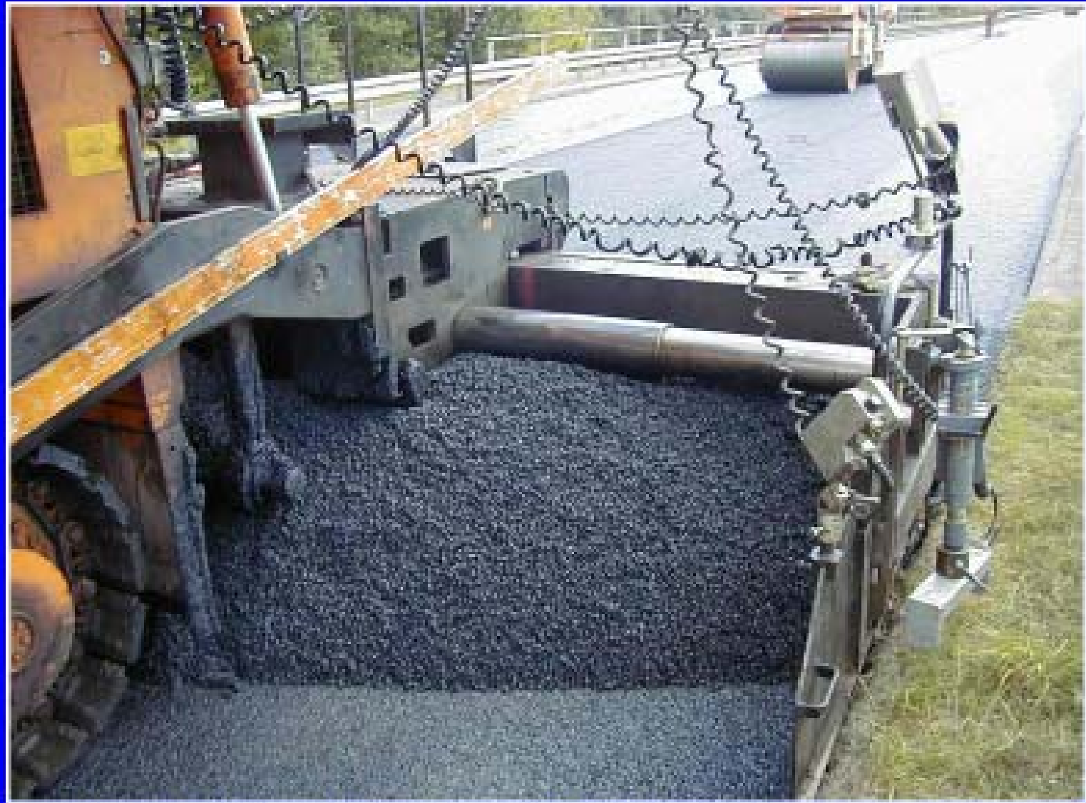
Verteilung des Mischgutes in ganzer Einbaubreite vor die Variobohle
